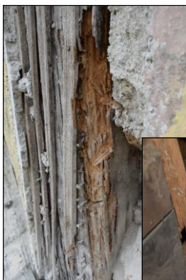
Mauerbank Dachstuhlauflager, Unterkonstruktion -Fasadengesimse
