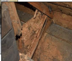
Mauerbank Dachstuhlauflager, Unterkonstruktion -Fasadengesimse
